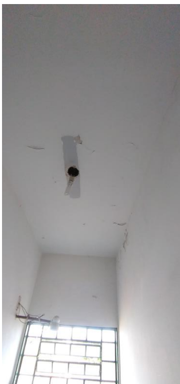
Fotos 66, 67 e 68: Banheiro Masculino com Laje e Azulejo Danificados
