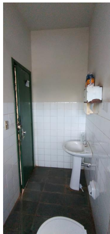
Fotos 66, 67 e 68: Banheiro Masculino com Laje e Azulejo Danificados
