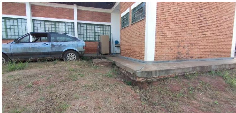
Foto 23: Calçada Interna Danificada
