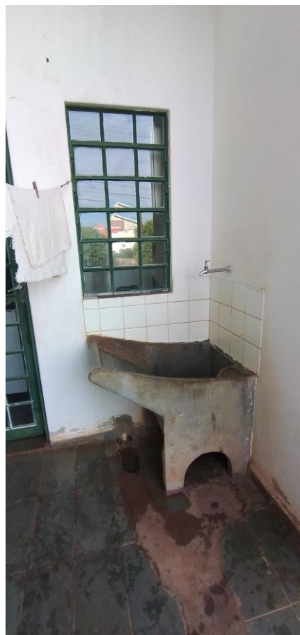
Foto 19: Tanque da Área de Serviço Danificado
