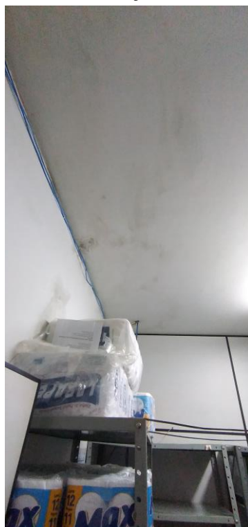
Fotos 56 e 57: Arquivo com Laje Danificada
