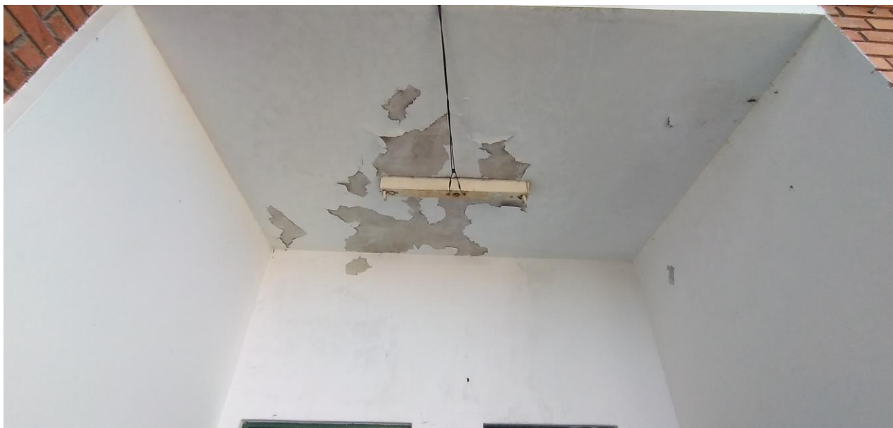
Foto 20: Laje da Área de Serviço Danificada
